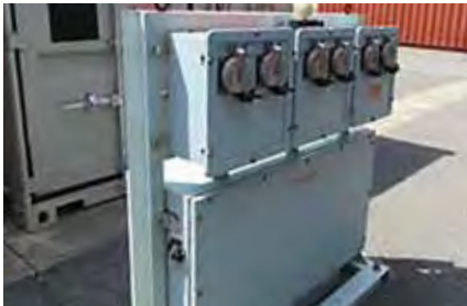
リーファーコンテナコンセント設備 Reefer Container Outlet Equipment
